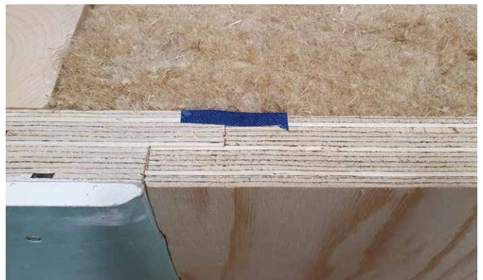
Abgeklebte Stufenfalzplatte mit Dämmung.
