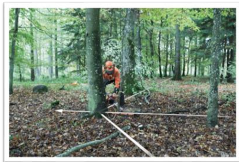
28.att. Atkāpšanās ceļu izveidošana
